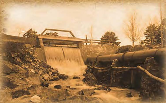
Le tuyau du moulin menant vers la turbine
